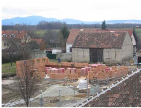
Mannschaftsgebäude: Rohbau Untergeschoß
