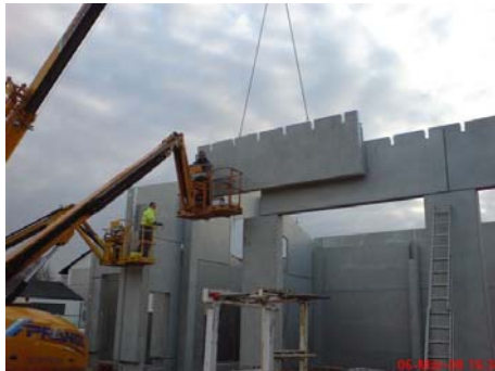
Letzter Bauteil der Fahrzeughalle
